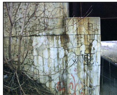
(d) Severe ASR Cracking
